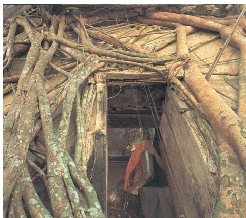
การถูกทำลายโดยต้นไม้ใหญ่ที่ขึ้นบนอาคาร โดยเฉพาะต้นไทรซึ่งเป็นไม้ในสกุล Ficus
